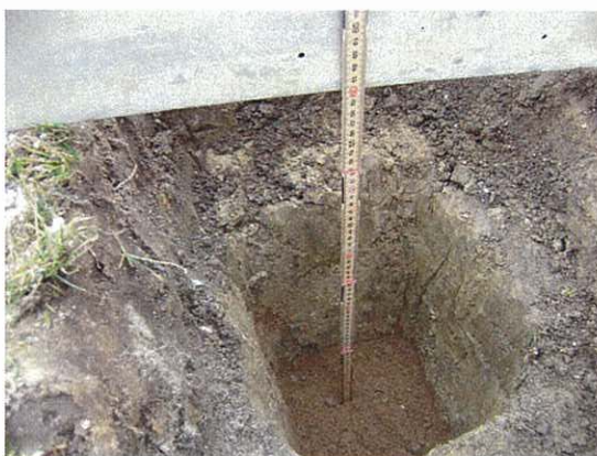
Retteskinnen bliver lagt over hullet, Tommestokken bliver sat fast.
