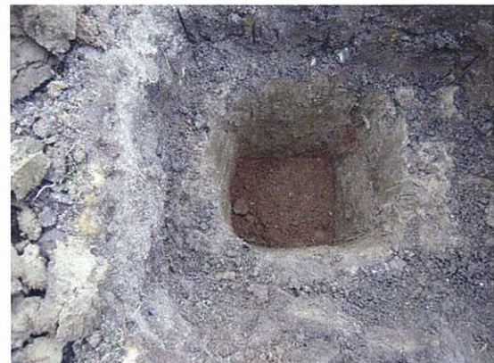
Der er fyldt 5 cm grus i bunden af hullet.
