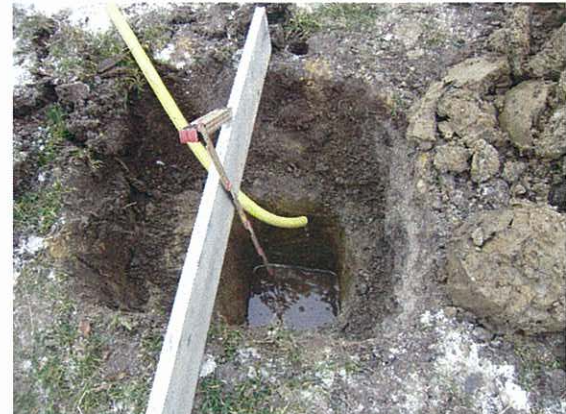
Der bliver hældt vand i hullet, for at vandmætte jorden til vandmætningstesten.
