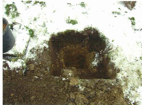
Hullet er gravet ca. 0,3 x 0,3 x 0,4 (l x b x d)
