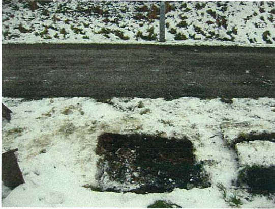
Ved cykelsti laves et infiltrationshul. Muldjorden fjernes.
