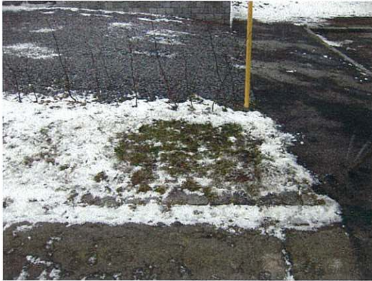
Mellem Agernvej 6 og cykelsti laves et infiltrationshul.
