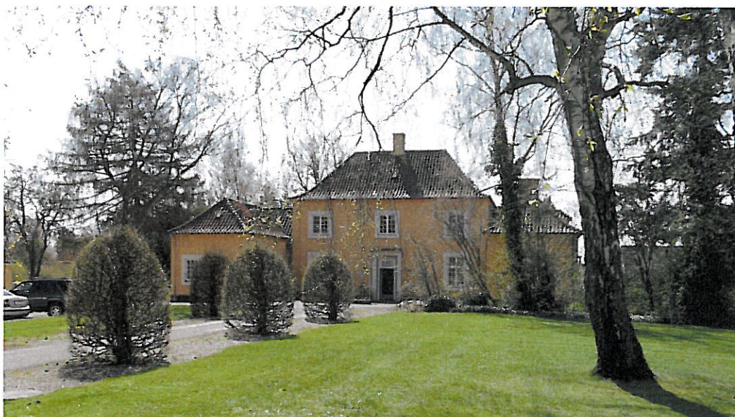
Dr. Sells Vej 26 med buskflankeret indkørselsvej, set fra parken nord for bygningen.
