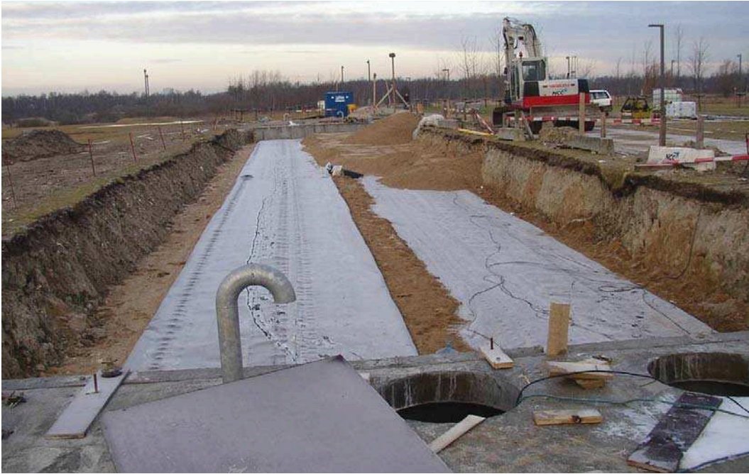
DPF-pilotanlægget i Ørestad. Bag indløbsbygværket ses de to test-filtre, DPF-6 og DPF-18, begge indpakket i en PE-membran. Bagerst skimtes udløbsbygværket. Efter opfyldning med grus og muld retableres plænen.
