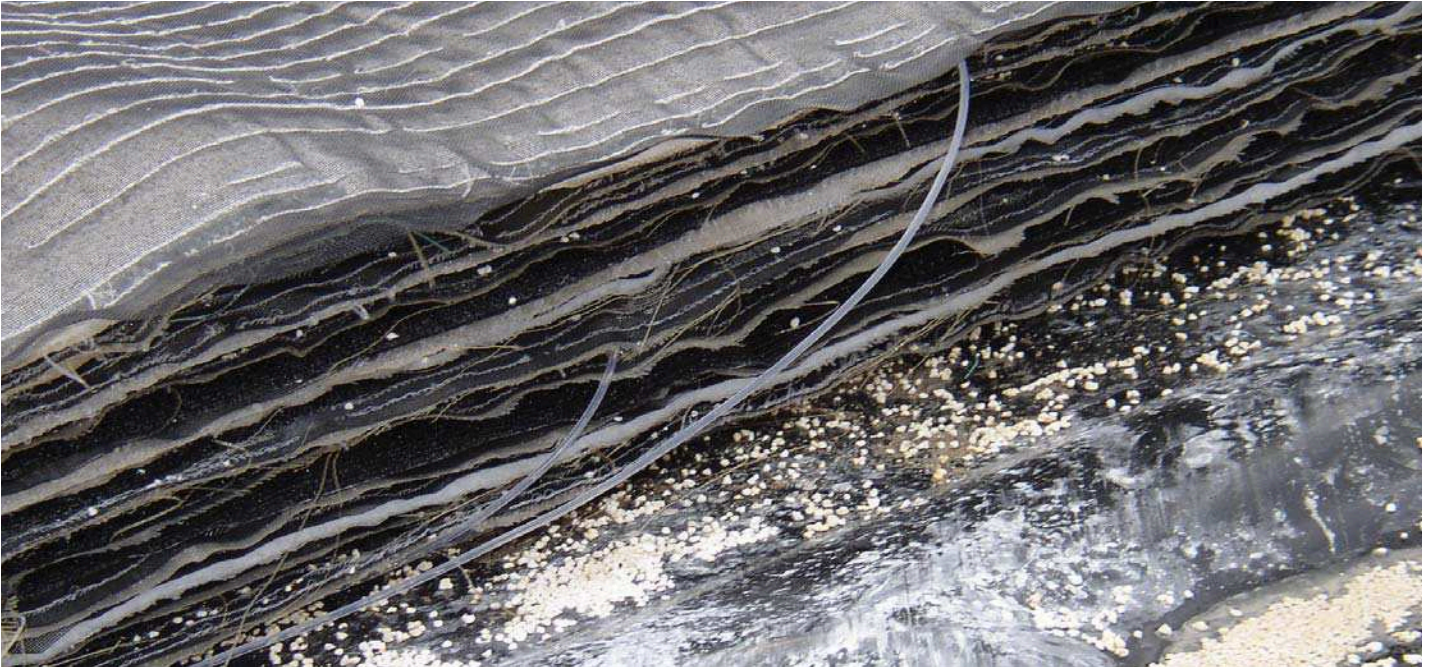
DPF-18 under opbygning i pilotanlægget i Ørestad. Øverst ses et lavporøst lag, bestående af kalk indsyet mellem to geotextiler. De højporøse lag, der er etableret vha. et hvælvet nylonnet, anes som sorte linjer mellem kalkmåtterne. For hver 10 m er der indlagt en tynd slange (ses som en hvid streg) i to udvalgte højporøse lag, med det formål at kunne udtage prøver af vandet under dets passage fra indløb til udløb (se Foto 1).
