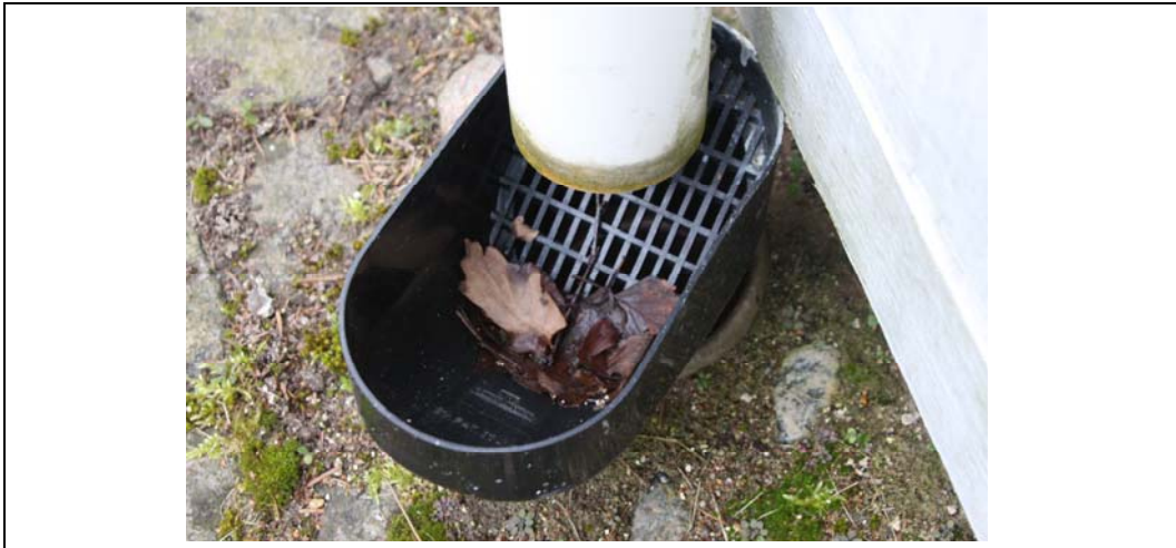
Figur 3.1 Grovfilter på tagedløb
