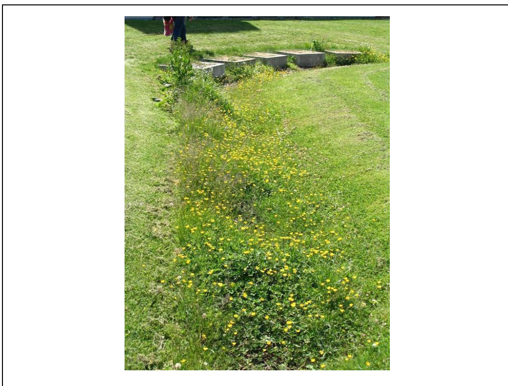
Figur 2.3 Rende med blomster i bunden og trædesten, der også forsinker vandet
