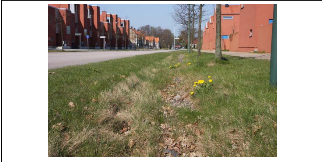
Figur 3.8 Eksempel på grøft med store sten i bunden, der kan bruges som trædesten
