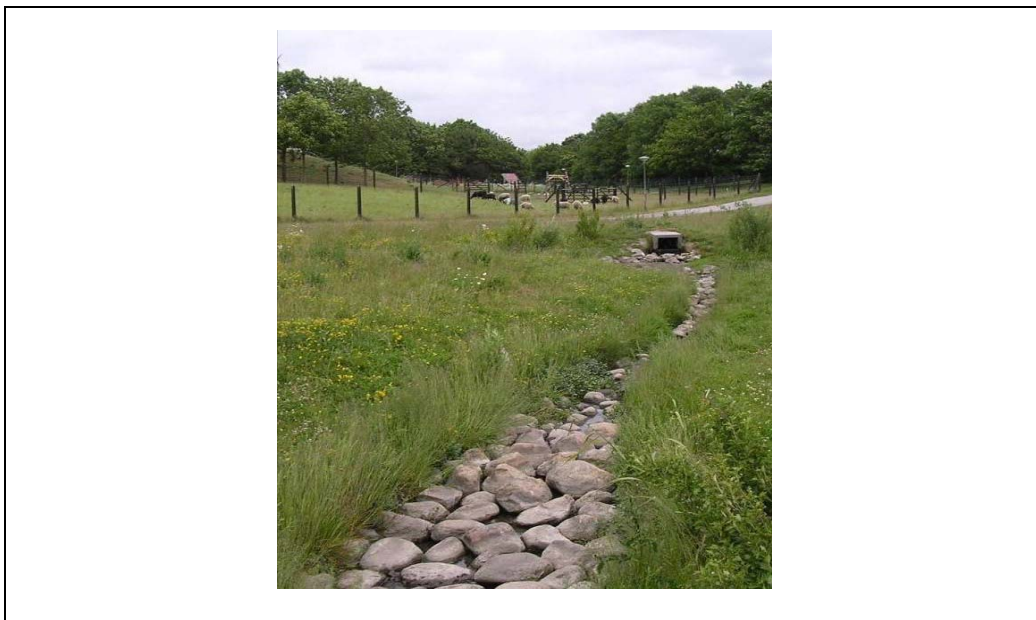
Figur 2.1 Grøft med store sten i bunden, som forsinke og ilter vandet samt øger nedslivningen
