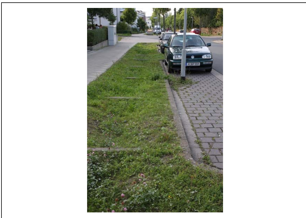
Figur 2.2 Eksempel på sektionering af grøft
