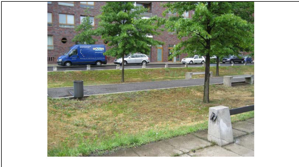
Figur 2.4 Grøfter afskærmet med pullerter langs mindre befærde vej
