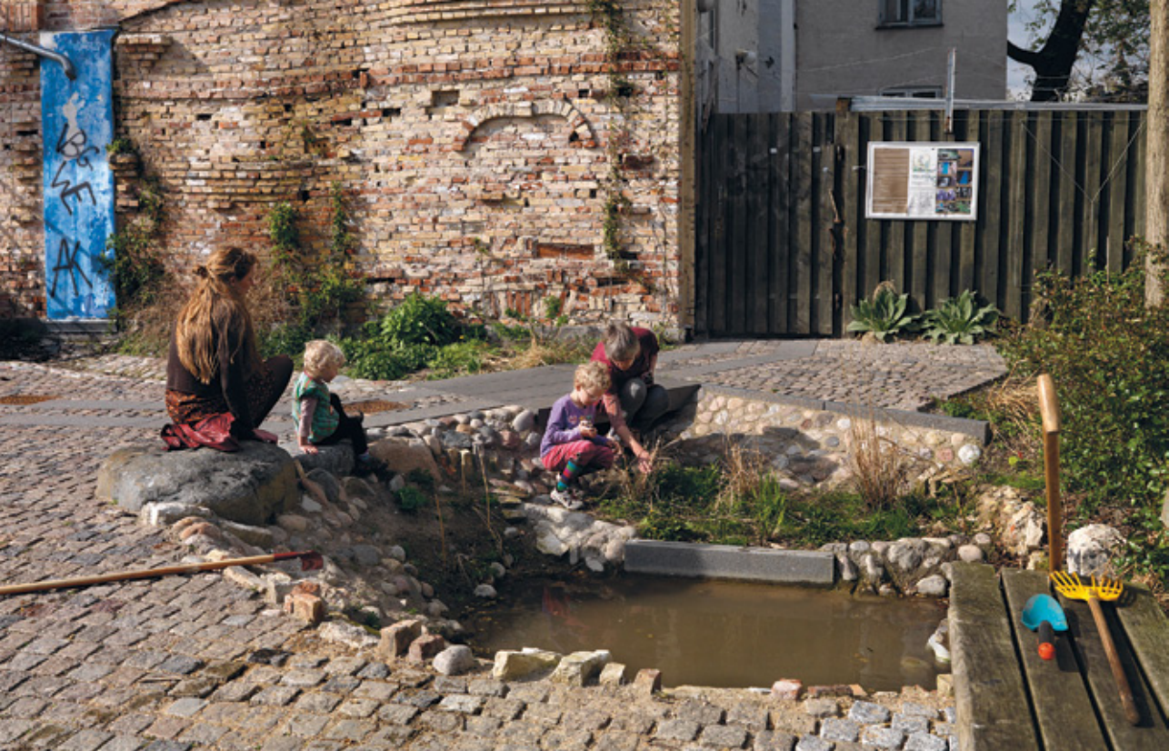
Foran muren findes et lille regnvandsbassin, der opsamler vandet fra gavlen.
