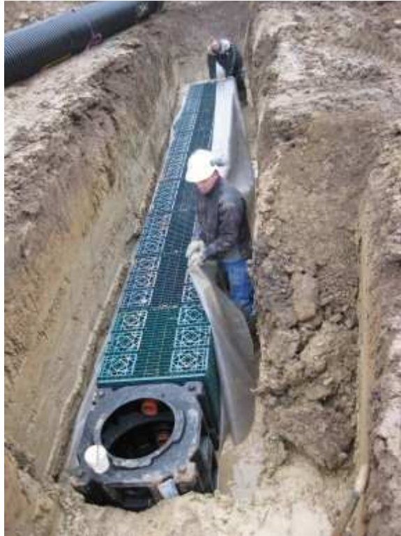
Figur 14, Fotografi af faskine nr. 3 under anlæggingen (19k, 2009d).
