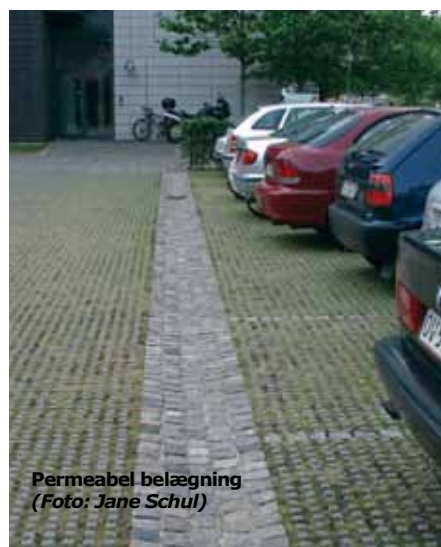
Granitsten med brede fuger, Ørestad (Foto: Københavns kommune)
