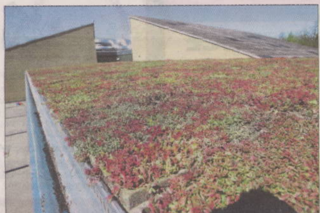
Seks forskellige slags stenurt er de planter, som skal suge regnvandet på Lindebjergskolens nye cykelskur. Et sted mellem 10 og 17 liter vand per kvadratmeter kan fastholdes i planter og den pude, planterne vokser i. Stenurt er de bedste planter til grønne tage, fordi de kan overleve måneder uden vand og kræver minimal vedligeholdelse.
