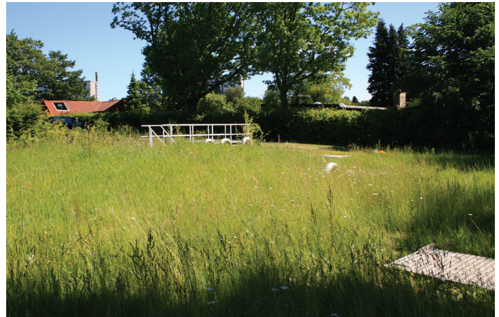
Underjordisk regnvandsbassin, jordpåfyld ovenpå ca 1 m, Beplantet med engmåtte på ca halvdelen af arealet. Forsyningens folk har også opsat flagermussebo, uglekasse og pindsvinekasser i skoven optil.
