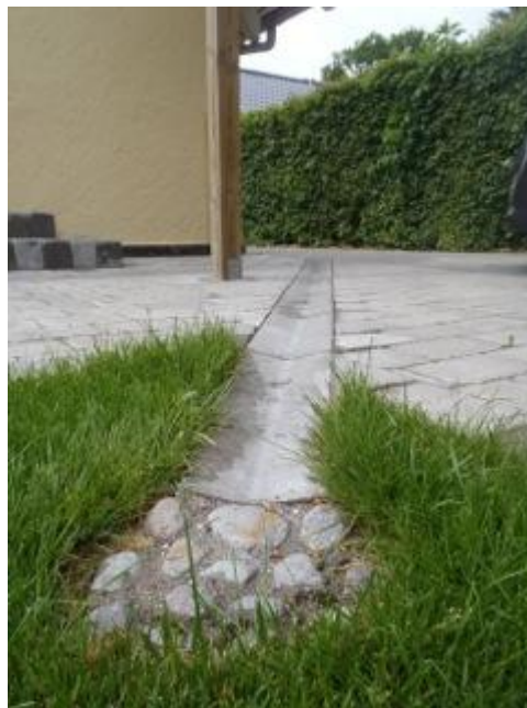
10. Vandrende i beton, foto: Avedøre Spildevand
