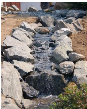
11. Havebæk der fordamper og nedsiver vand inden det løber i et regnbed. Foto: Peder Lund
