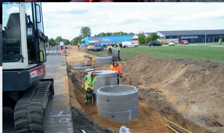
Ikast-Brande Kommune brugte første gang de nye permarrør og -brønde fra IBF Betonvarer i forbindelse med anlæg af en cykelsti i Brande.
