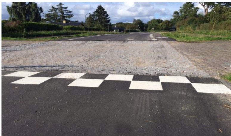
(Hastighedsregulerende permeabelt brostensbump)
