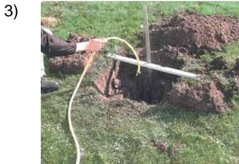
Vandmætning til ca. 30 cm over gruslag
