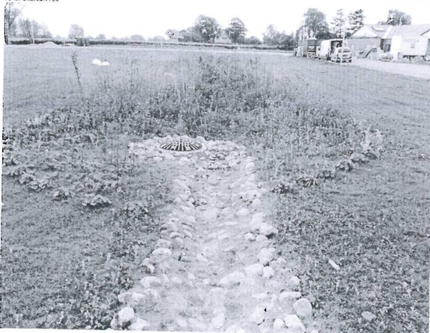
Forskellige typer render og andre anlæg anvendes til at kanalisere regnvand til steder, hvor vandet bliver nedsevet. Lokaliseringen af steder med god nedsivningsevne har været en udfordring i projektet.
