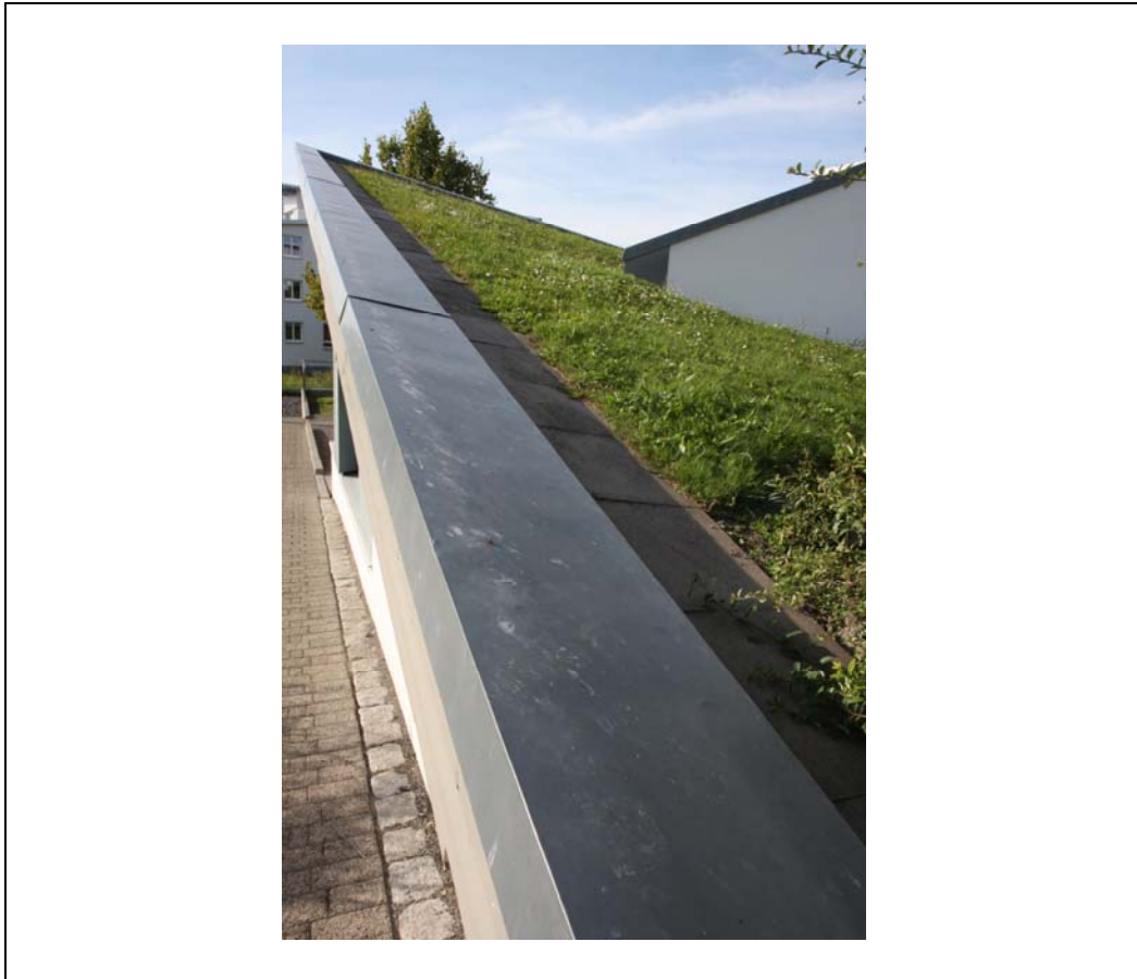
Figur 3.6 Skrånende tagflade på forsamlingsbygning i boligområde. Gangareal til vedligeholdelse langs tagkanten
