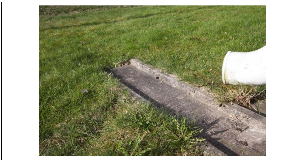
Figur 3.2 Eksempel på strømning af vand fra nedløbsrør til græsplæne
