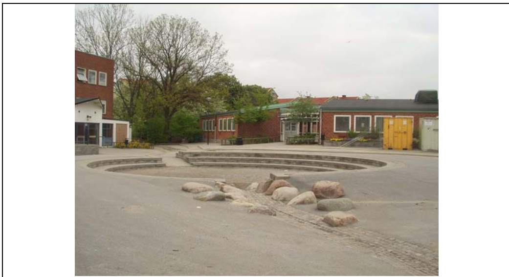
Figur 2.2 Eksempel på en plads, som er udført i sænket niveau og anvendt til regnvand under kraftigt nedbør
