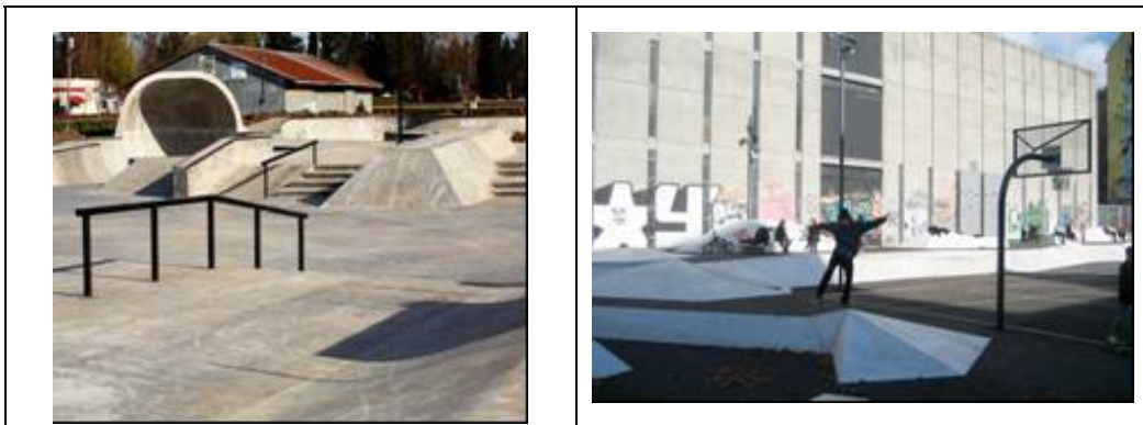
Figur 2.6 Eksempler på skaterbaner, som kan indrettes til opstuvning af regnvand under nedbør
