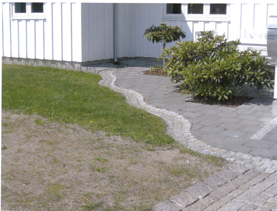
Figur 4. De fleste private render er udført i betonelementer. Der er dog enkelte, vellykkede eksempler på udnyttelse af regnvandsafledningen som et element i havens formgivning.
